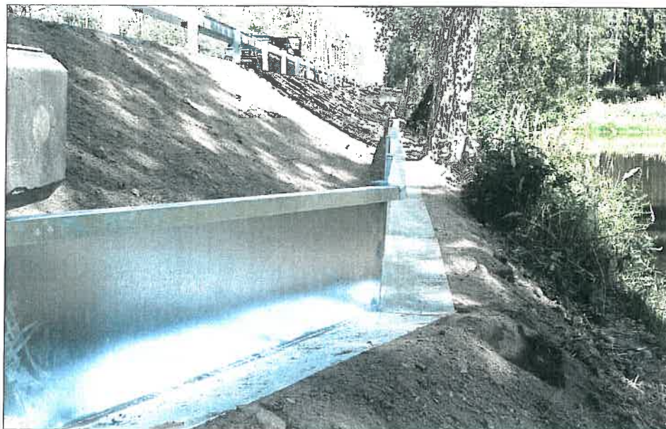
Obr. 21: Příklad trvalých zábran zhotovených ve svahu silnice (zdroj: SVOBODA & FRANCEK & ROZÍNEK 2015).
